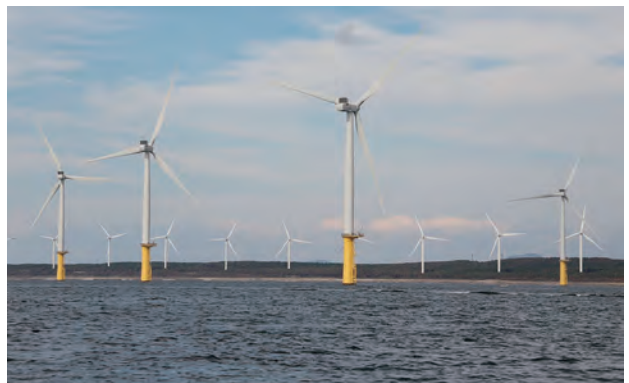
沿岸・洋上に林立する風車 (写真提供：秋田県)
