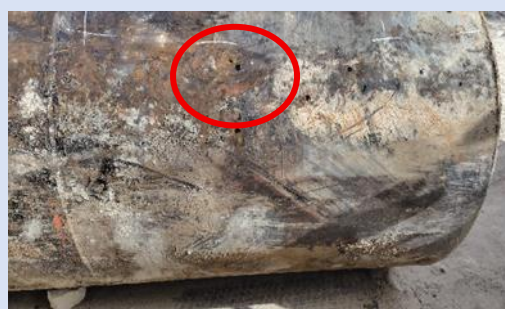
タンク本体（穿孔箇所）
