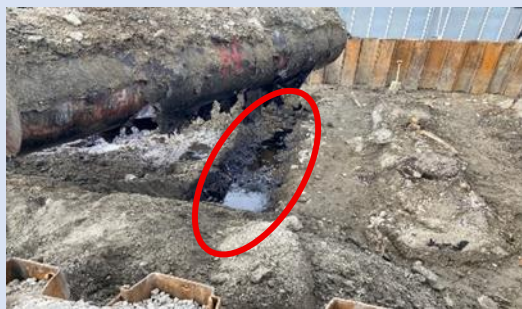
タンク堀上状況（漏洩だまり）
