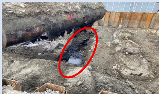
タンク堀上状況（漏洩だまり）
